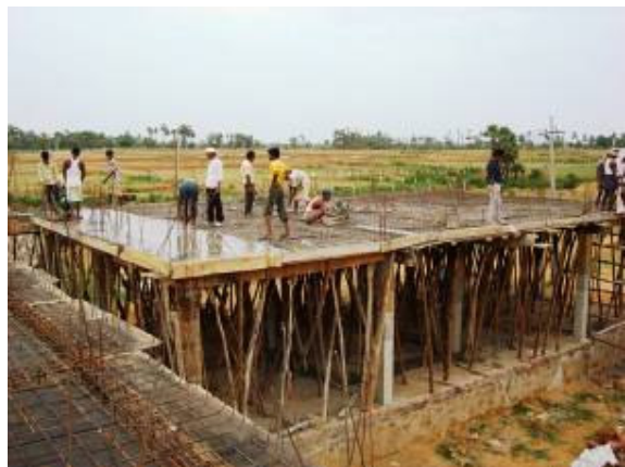
Het dak van de keuken
