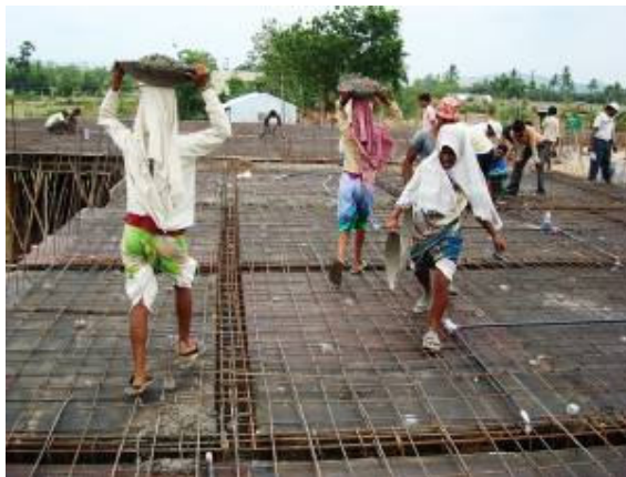
Het dak van het medisch centrum
