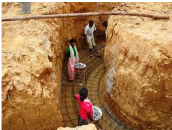
Fundament voor de watertank
